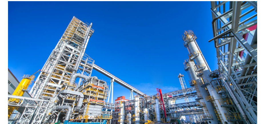
河钢全球首创的“焦炉煤气零重整竖炉直接还原”工艺技术
